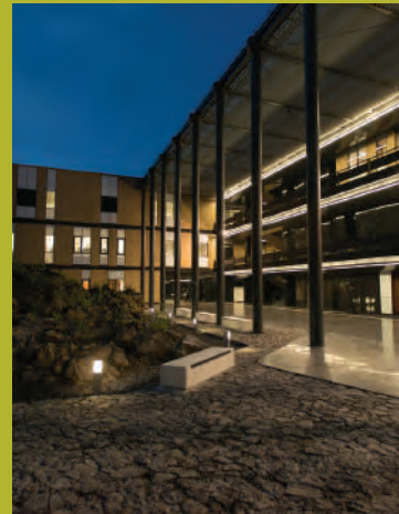
Instalaciones de Ciencia Forense, Facultad de Medicina
